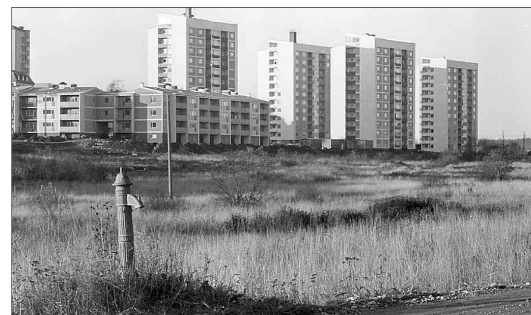
Vattenkastare. När Örnsköldsvik fick vatten från Hörnsjön leddes huvudledningen till "vattenkastare", pumpar, som länge stod kvar. Den sista fanns vid Vikingagatan och ses här med höghuset i kv. Älgen i bakgrunden.
