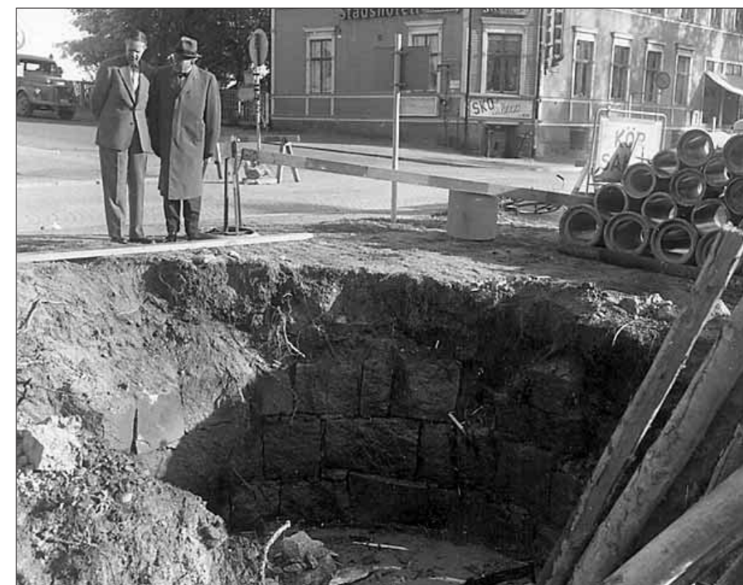
Vattenbrunn. Vid Lasarettsgatan-Centralgatan fanns sedan lång tid stadsbrunnen där Ö-viksborna hämtade vatten. En liknande brunn fanns vid Nygatan-Centralgatan. Bilden togs i början på 1960-talet då E4 drogs fram i sin nuvarande sträckning genom Örnsköldsvik. Sven Nordström och Icar Hus kunde då studera brunnens stenblock, som kläddes väggarna. I bakgrunden fastigheten Lasarettsgatan 24 med Skohörnan, nu ÖA:s parkeringsplats.
