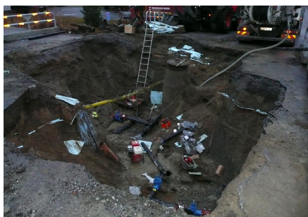
Så här kan ett ventilbyte i en korsning se ut.
